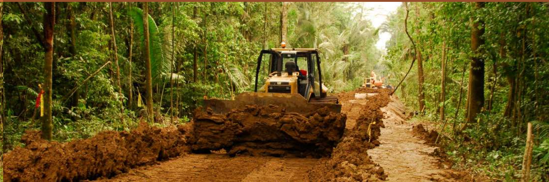
Construcciones de infraestructura y vialidad
